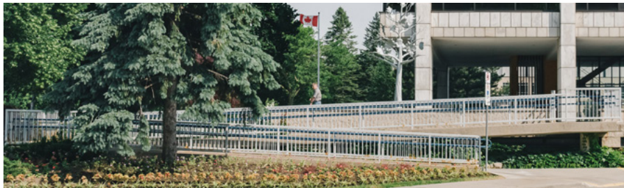
Фото 2. Нормативний пандус на перепаді висот для входу до будівлі.
